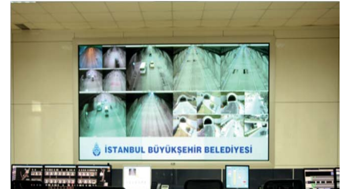
Tünel İşletim Merkezi
